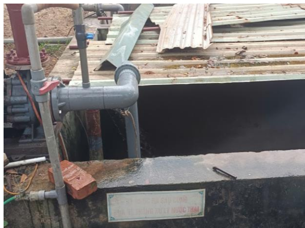
Bể chứa nước thải sau xử lý
