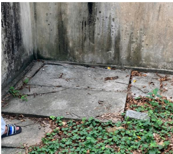
Hình 13. Hình ảnh vị trí hố ga thoát nước mưa và điểm đầu nối vào mương thoát nước khu vực
