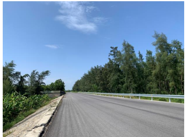
Đường đê ven biển gần nhà máy
