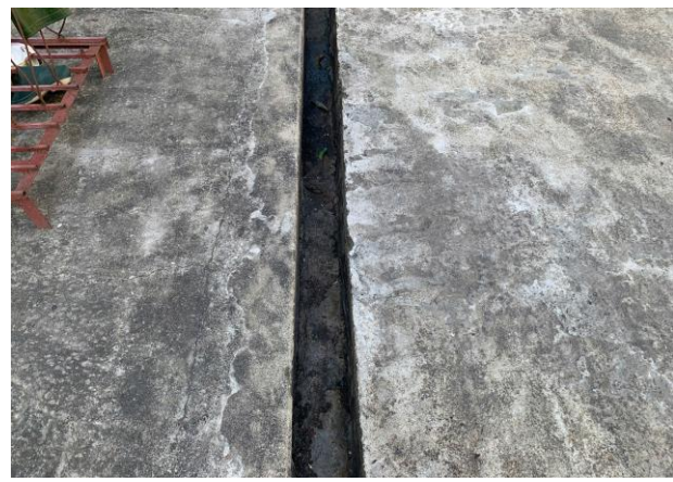
Hình 12. Hình ảnh hệ thống thu gom nước mưa của cơ sở
