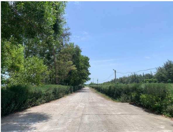
Đường vào nhà máy
